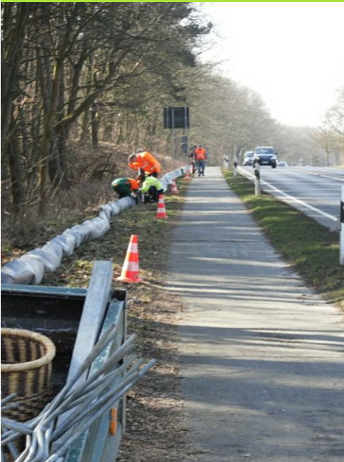
Bau der Krötenzäune
