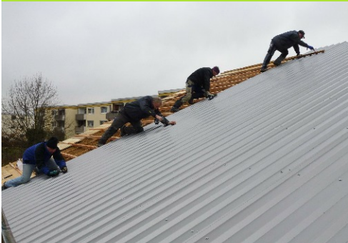
Auf dem Dach ...
