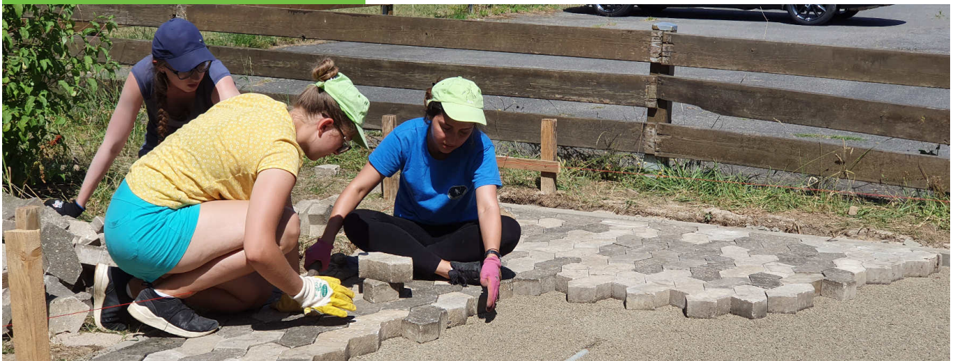
Arbeiten am Untergrund für das neue Gartenhaus
